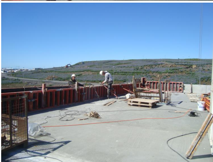
Hús B, Unnið við portveggi á þaki
