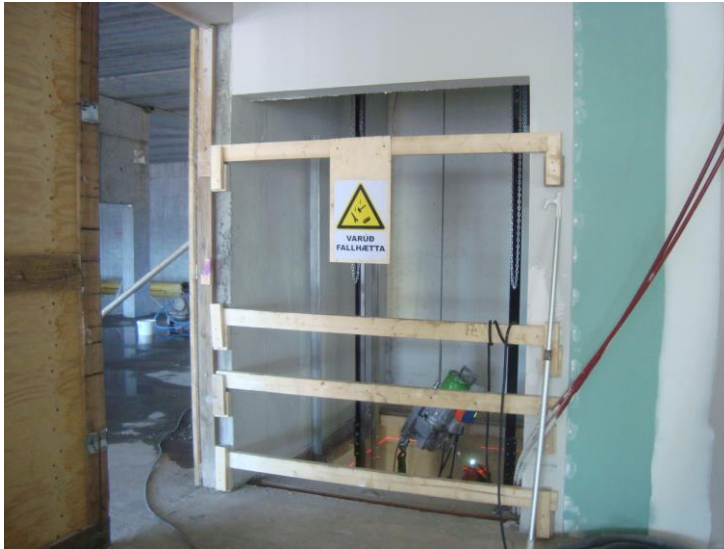
Hús C unnið í uppsetningu á lyftu.
